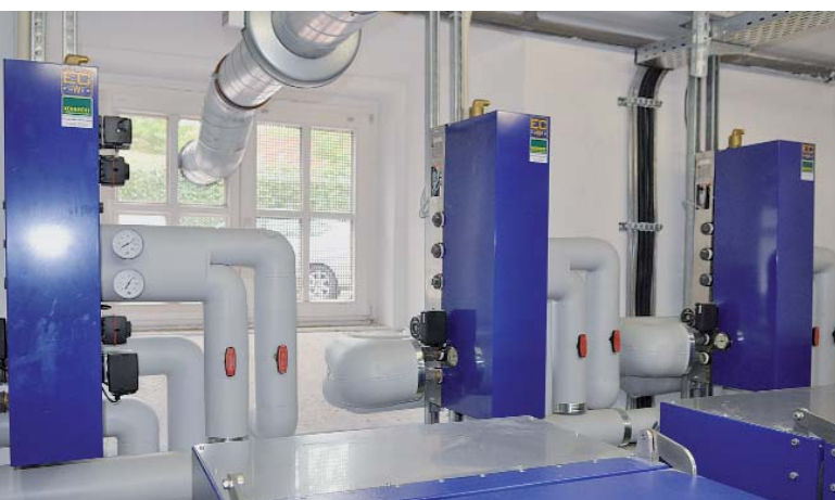
Das komplette System, bestehend aus den BHKW-Einheiten, der Hydraulik (im Bild), den Regelmodulen und dem Speicher.
