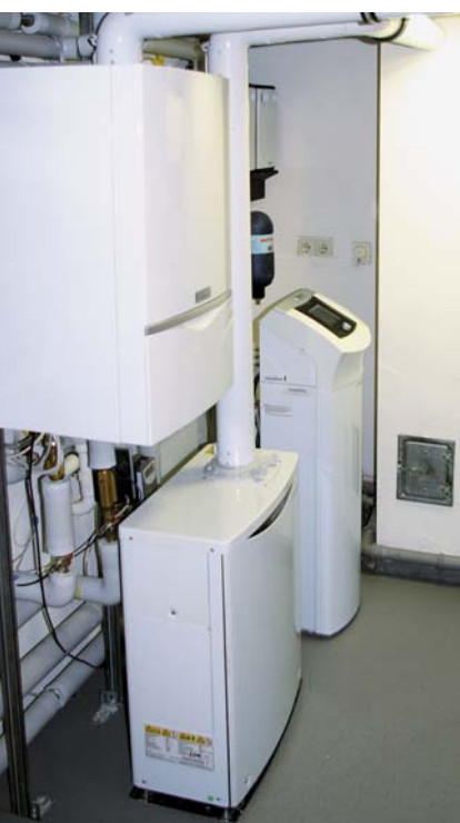
Kompakt, laufruhig und leistungsstark: Vaillant und Honda haben mit „ecoPOWER 1.0“ (vorn unten, darüber das Brennwertgerät für die Spitzenlast, im Hintergrund die Regelung) den Markt für Kraft-Wärme-Kopplung im Einfamilienhaus aufgemacht. (Fotos: Martin)
